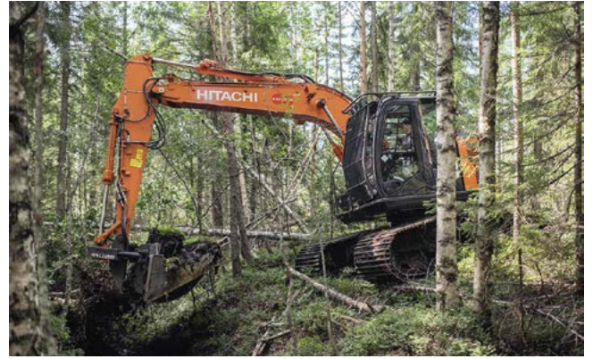
Kaivuri töissä. Kuvaaja Marko Haapalehto/Metsähallitus.
